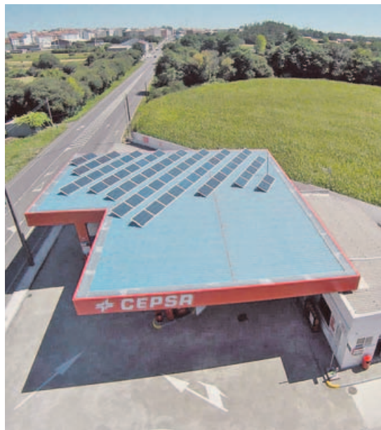
Las electrolineras se alimentan, en parte, con paneles solares.
