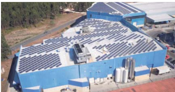
Instalación de autoconsumo en empresa del sector pesca en A Coruña.
