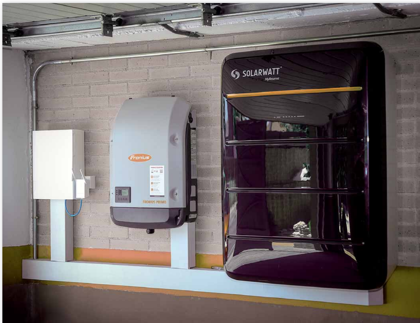
De derecha a izquierda, la batería de acumulación, con la tapa negra, el inversor, con la carcasa en gris y el EnergyManager, con la carcasa blanca.
